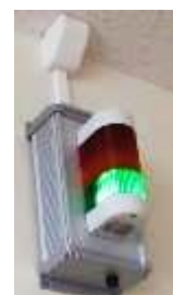
パトライトの設置 赤色・・・緊急時 黄色・・・チャイム
